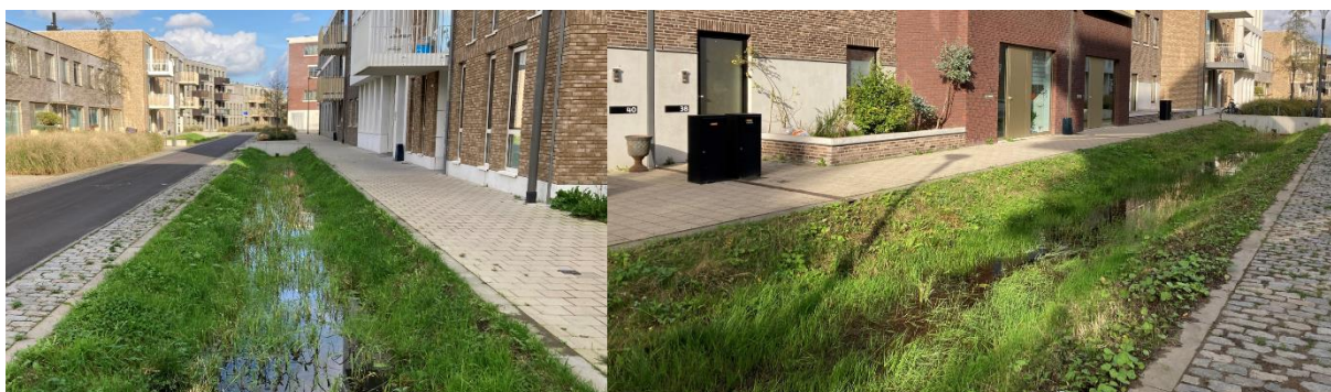
Figuur 33. Voorbeeld van verlaagd ingerichte groenstroken, in Hoboken (Schaapskooi). Door deze groenelementen verlaagd en bereikbaar voor water in te richten, met een overloop in de groene berm i.p.v. een kolk in de goot, krijgt regenwater de tijd om (vertraagd) te infiltreren en kan het eventueel overtollig water vertraagd worden afgevoerd.
