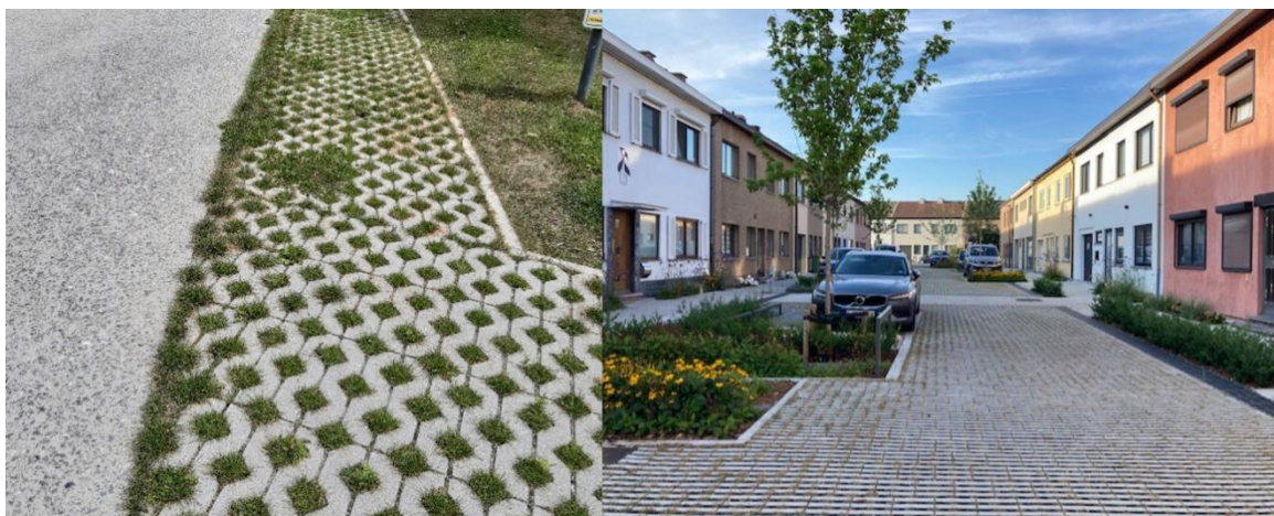
Figuur 27: Vlnr: (1) Versmald voet-fietspad met uitwijkmogelijkheid over waterdoorlatende verharding (Overijse). © Aquafin; (2) Tuinstraat met zowel rijweg als parkeervakken aangelegd in halfverharding (Aziëlaan, Wilrijk). © Aquafin.
