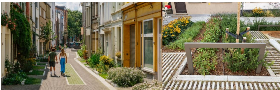
Figuur 28. Vlnr: (1) Ontharding met boven- en ondergrondse infiltratie in centrum Antwerpen. © Aquafin; (2) Infiltrerende plantvakken in Aziëlaan (tuinstraat Wilrijk). © Aquafin
