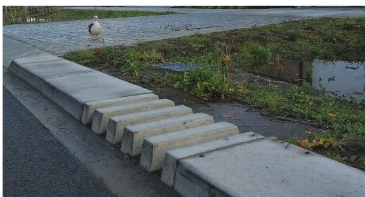
Figuur 34. Een voorbeeld van een boordsteen met spleten zoals toegepast in de Fortstraat in Mortsel (Bron: dbpubliekeruimte.info).
