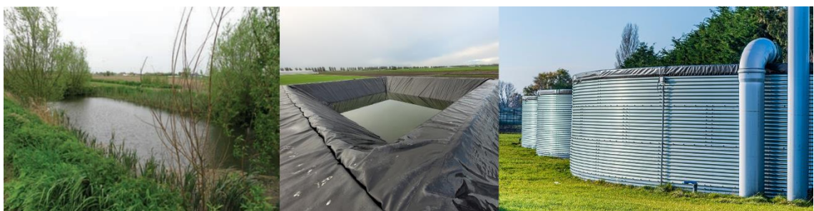
Figuur 44: vlnr: 1) Open bufferbekken. Bron: Aquafin. 2) Foliebassin. Bron: Inagro. 3) Watersilo. Bron: Waterportaal.
