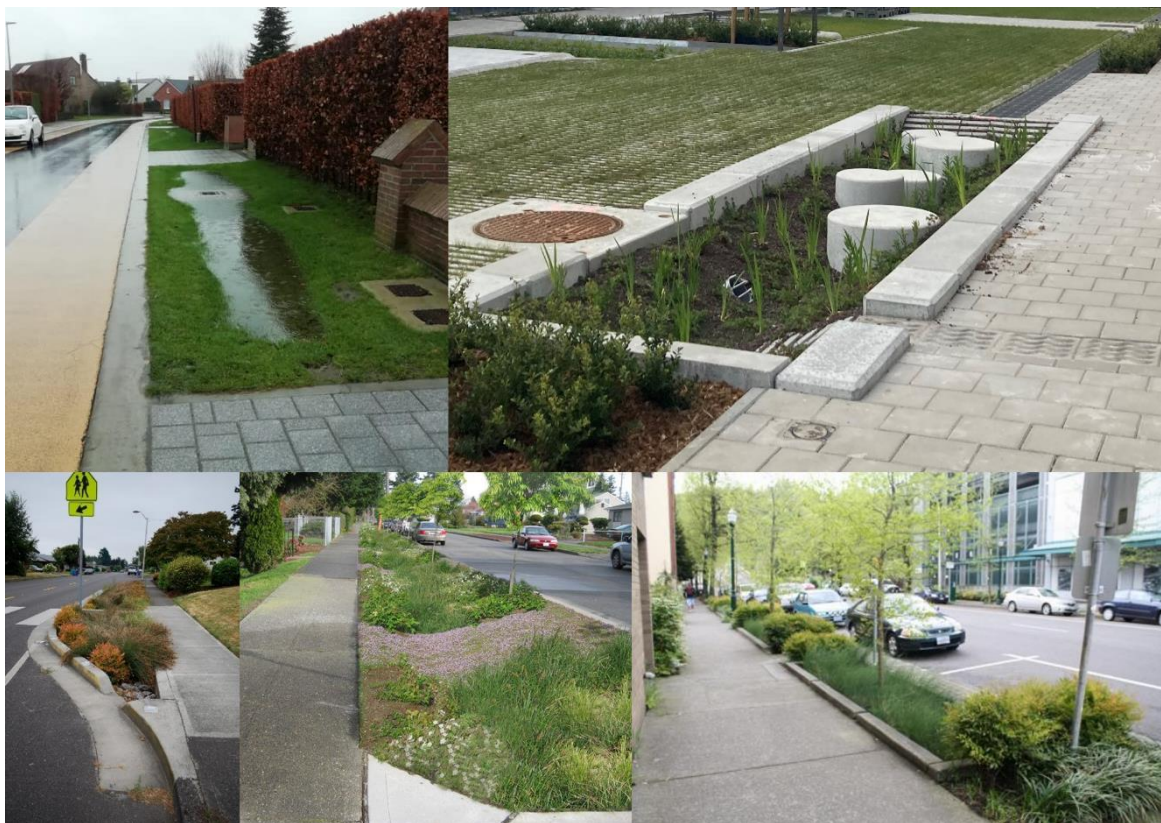
Figuur 29. Vlnr en vbno: (1) Infiltratiekom langs de straat. © Kruisem; (2) Bufferend plantvak (Aziëlaan Wilrijk, tuinstraat). © Aquafin; (4, 5 en 6) Mogelijke vertragingsmaatregelen waarbij de inplanting zoveel mogelijk wordt uitgespreid en focust op water vasthouden. © Aquafin.
