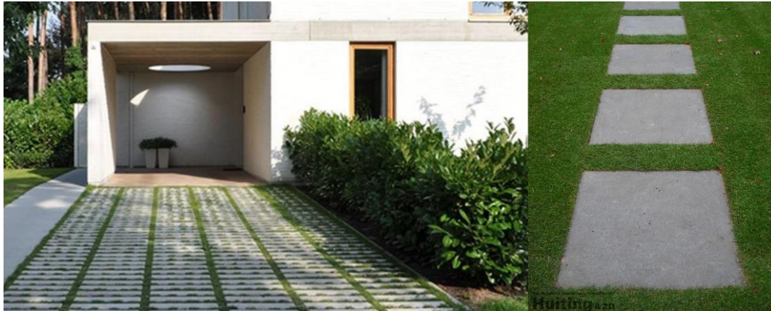
Figuur 41. Oprit in waterdoorlatende verharding.
