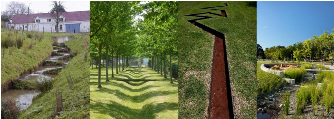
Figuur 38. Blauwgroene netwerken bieden een breed spectrum aan inrichtingsmogelijkheden. Van links naar rechts: een gracht met kunstmatige meandering om te vertragen, een laanvormige infiltratiekanaal, een zeer strak vormgegeven meandering en een waterspeeltuin waar afhankelijk van de waterstand delen rond de speeltuin zich vullen of de speeltuin mee overstroomt.
